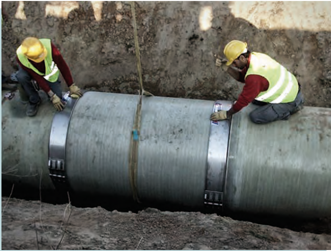
Bsp. 1 / Montage eines GFK Rohres grossen Durchmessers.
