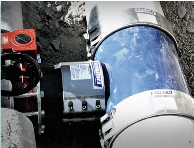
Bsp. 3 / Montage von Rohren und Anbauteilen aus verschiedenen Materialien.
