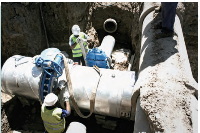
Bsp. 6 / Montage von Rohren und Anbauteilen.
