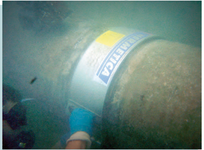
Bsp. 2 / Montage Unterwasser. HERMETICA SF Schelle aus rostfreiem Stahl AISI 316.
