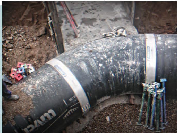
Bsp. 4 / Montage von Gusseisenrohren und Anbauteilen.
