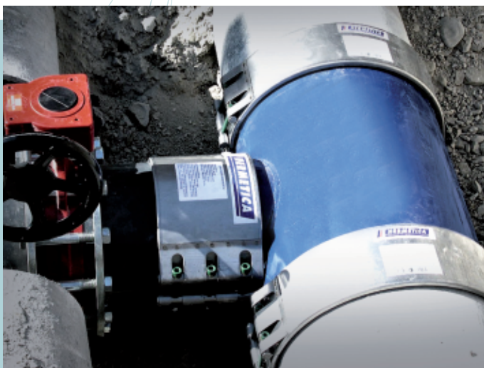
Fig. 3 / Montage des conduits et accessoires des matériaux différents.
