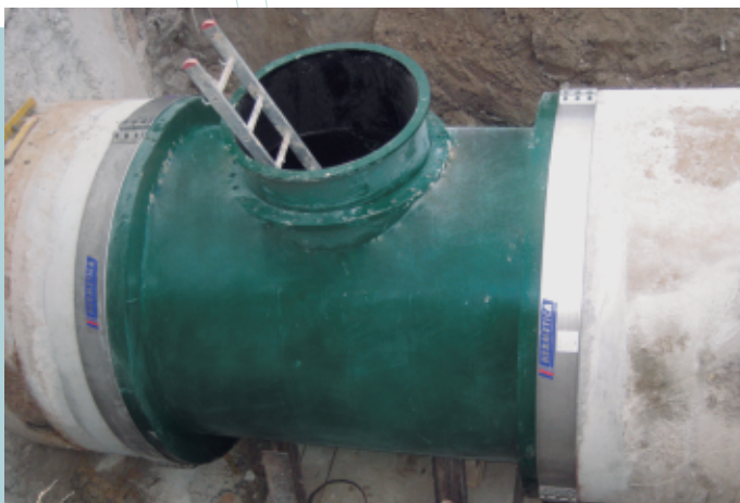
Fig. 5 / Installation d'un point de inspection dans un conduit du grand diamètre.
