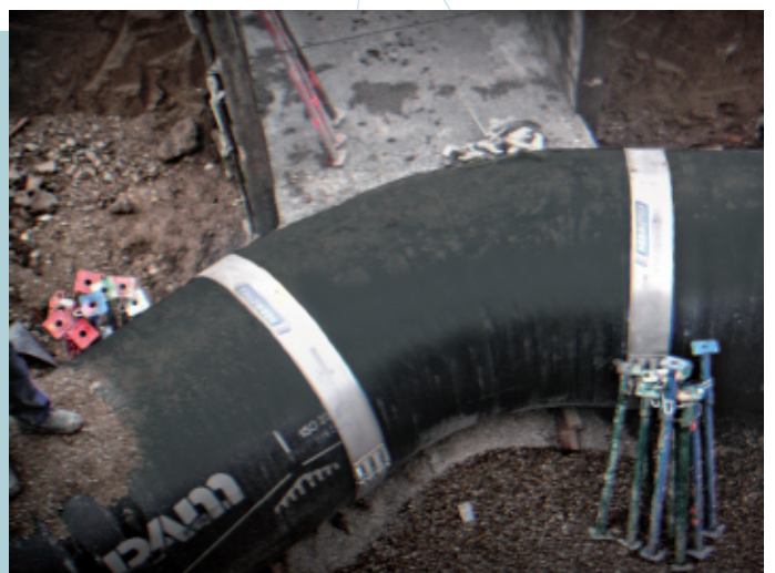
Fig. 4 / Montage d'un coude dans un conduit de fonte.
