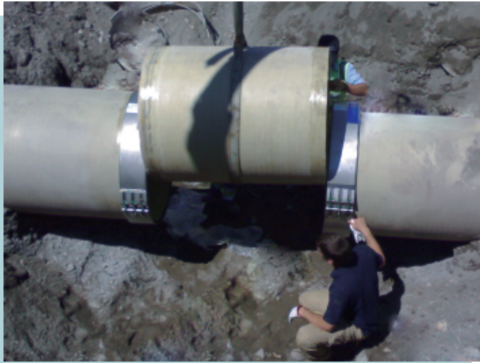
Fig. 1/ Montage avec une pièce nouveaux dans un conduit PRV du grand diamètre.
