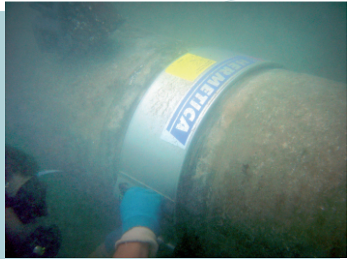
Fig. 2/ Montage subaquatique. Raccord HERMETICA SF fabriqué d'acier inoxydable Duplex.
