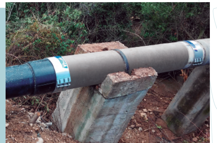
Fig. 6 / Réparation des conduits élevés avec des matériaux et diamètres différents.
