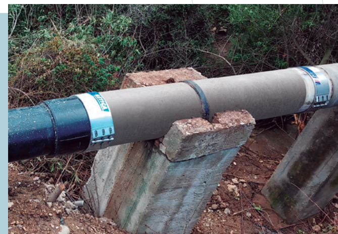
Fig. 6 / Riparazione di tubazione aerea di differenti diametri e materiali.
