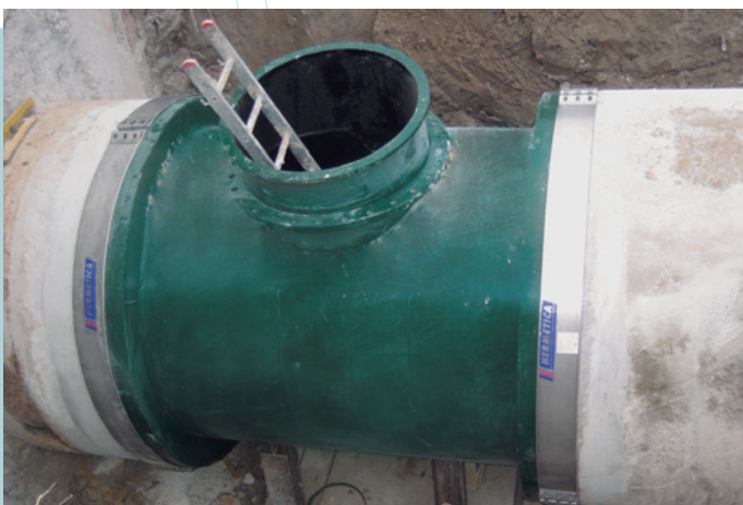
Fig. 5 / Installazione del pozzetto d'ispezione per tubazioni di grande diametro.
