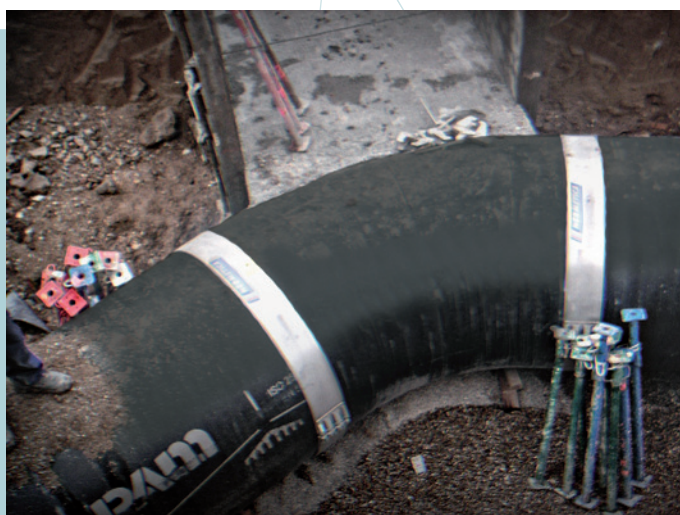
Fig. 4 / Montaggio di gomito in tubazione di ghisa.
