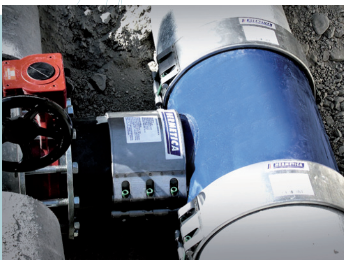
Fig. 3 / Montaggio di tubazioni e accessori in materiali differenti.
