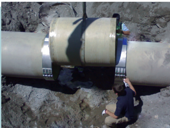
Fig. 1 / Riparazione con tratto di tubo in tubazione di grande diametro in FRP.
