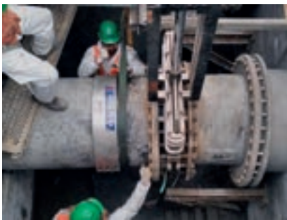
Einbau von Meß- und Kontrollelementen.
