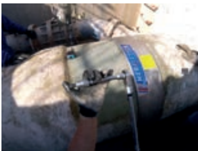
Reparatur eines GFK Rohres.
