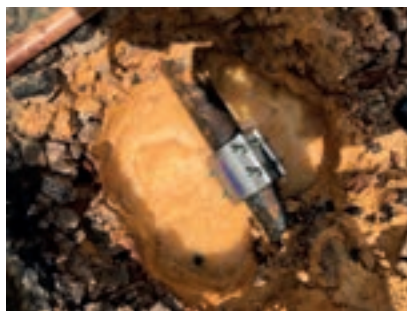
Reparatur unter Druck.
