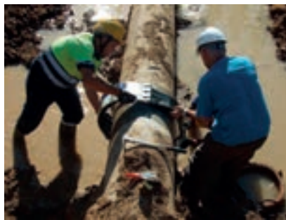
Austausch von Gibault Rohrverbindungen.
