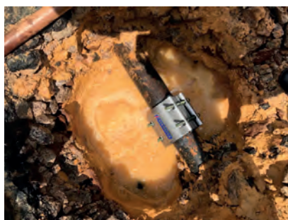
Reparo sob pressão.
