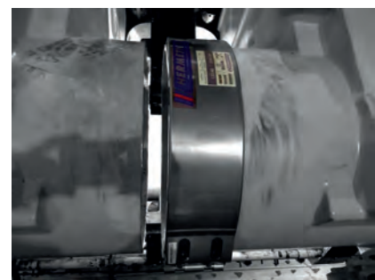
Conexão de tubos em planta industrial.
