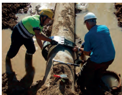
Reposição de juntas Gibault.
