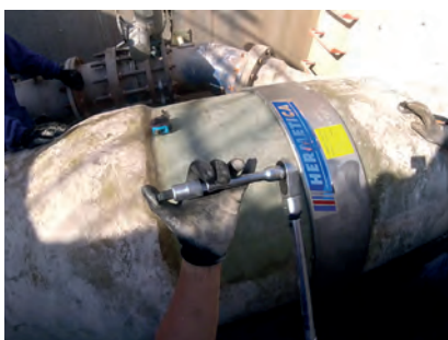
Reparo em tubo PRFV.
