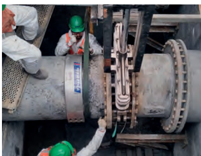
Instalação de elementos de controle e regulação.
