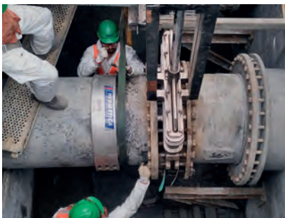
Instalação de acessórios de controlo e medição.
