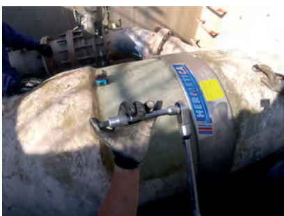
Reparação de um tubo PRFV.
