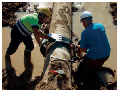
Substituição de juntas de tubo Gibault.
