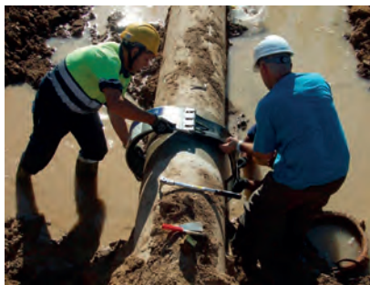
Gibault csőösszekötések cseréje.
