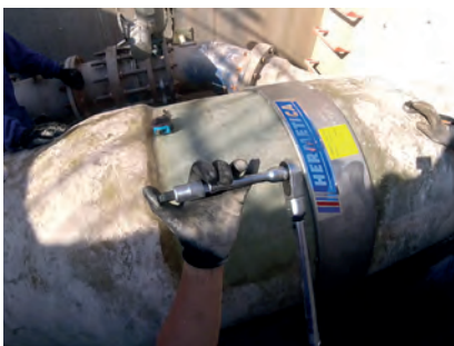
GFK cső javítása.
