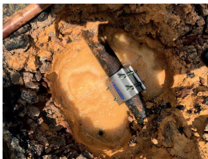
Reparación en carga.
