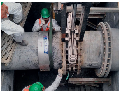
Instalación de elementos de control y regulación.
