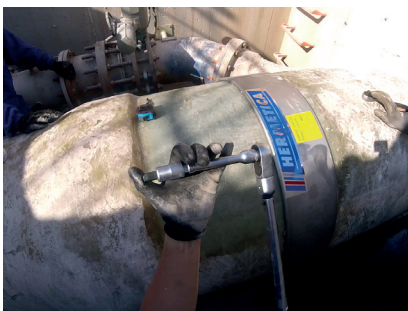
Reparación en tubería de PRFV.
