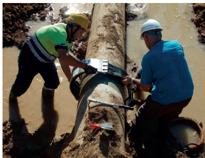
Sustitución de juntas gibault.
